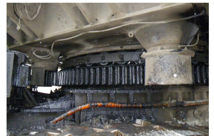
Drehkranz eines Schaufelradbaggers geschmiert mit Berulit GA 2500
